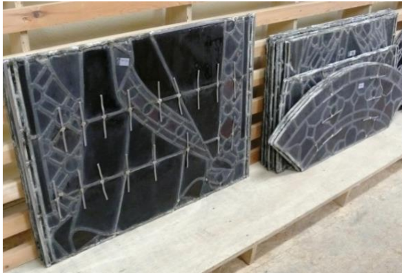
Bindloodjes (platte strips op de horizontale loodstrips) waarmee de panelen tegen de bindroeden worden bevestigd.
