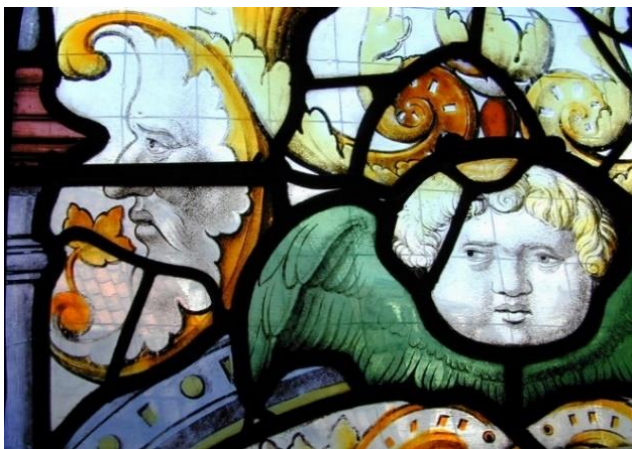
De smalle loodstrips zijn breukloodjes die oudere breuken in de glasruitjes afdichten. Tegenwoordig zou lijmen van het gebroken glas een goede optie zijn.
